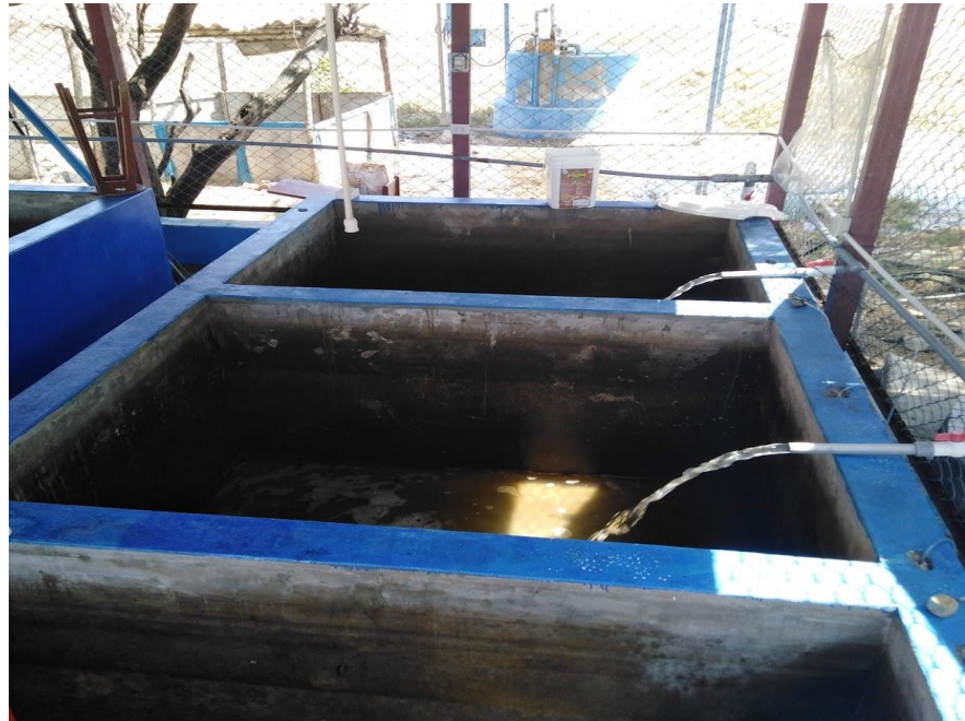
Figura 4. Llenado de tanques de concreto (Imagen del propio autor).
