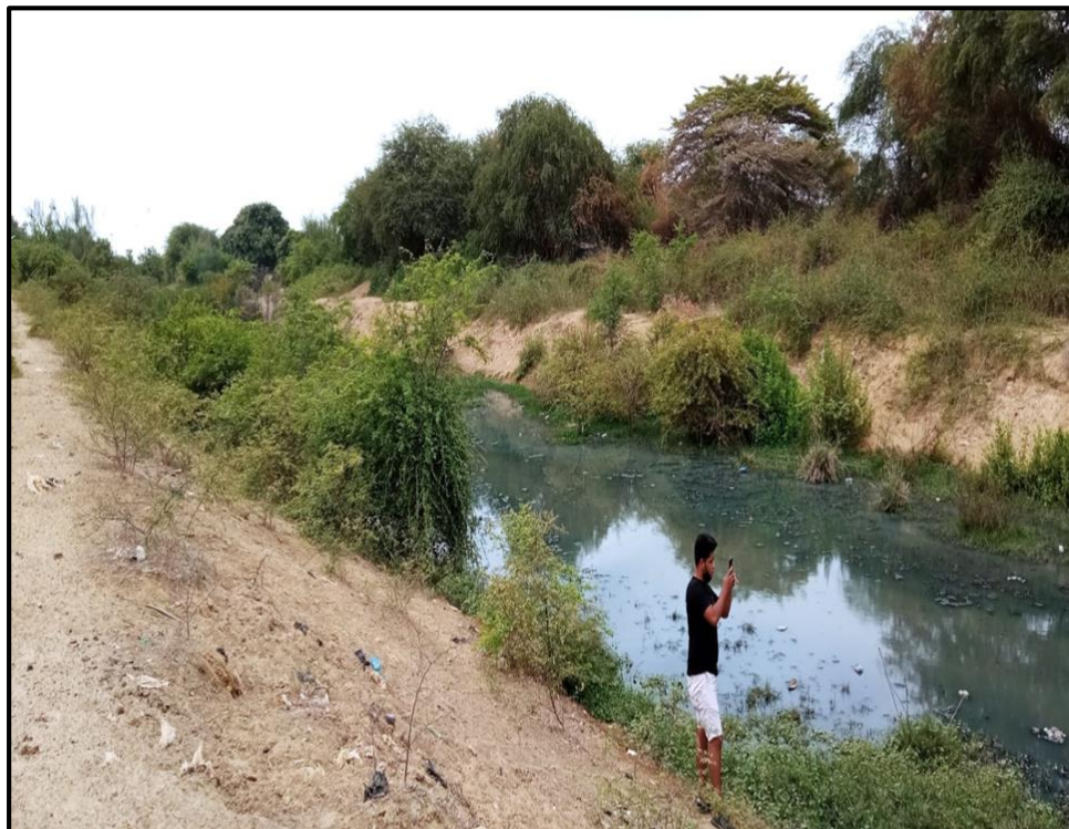
Cauce colmatado de maleza
