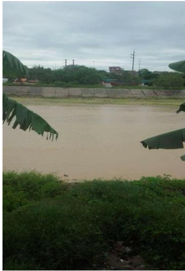
Figura Nº 12 Activación de la quebrada en marzo del 2017
