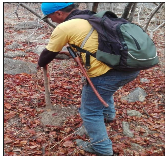
Imagen N° 13. Introducción e instalación de estacas.
