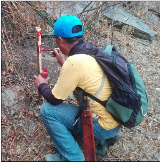
Imagen N° 14. Pintado y enumeración (P1, P2, P3, P4) de estacas.
