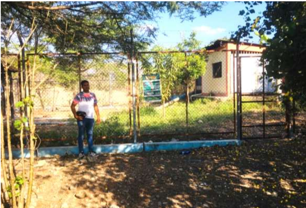
Foto 12: Estación de Bombeo de la JASS Manantiales de Huarapal
