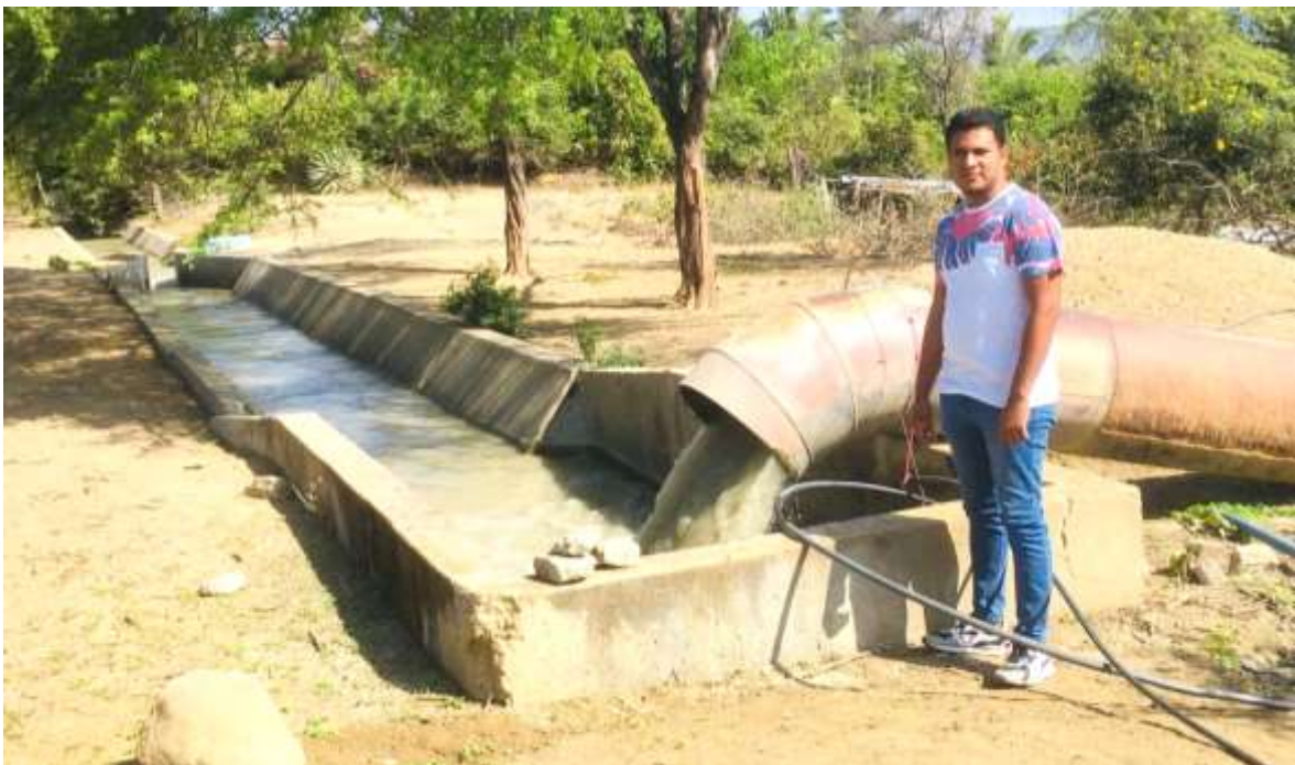
Foto 14: Pozo de descarga Estación de Bombeo Becerra Belén – Observe el agua contaminada del Río Tumbes
