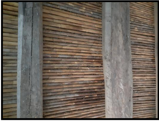
Img. 26: Vigas de Nogal
