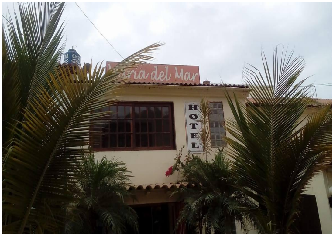
INSTALACIONES DEL HOTEL MARÌA DEL MAR – ZORRITOS INSTALACIONES DEL HOTEL COSTA AZUL - ZORRITOS
