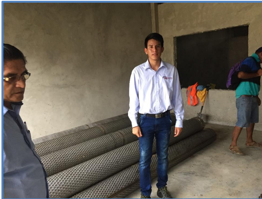
Fotografía 13 TUBERÍA FILTRO PARA EL POZO TUBULAR DE LOMA SAAVEDRA
