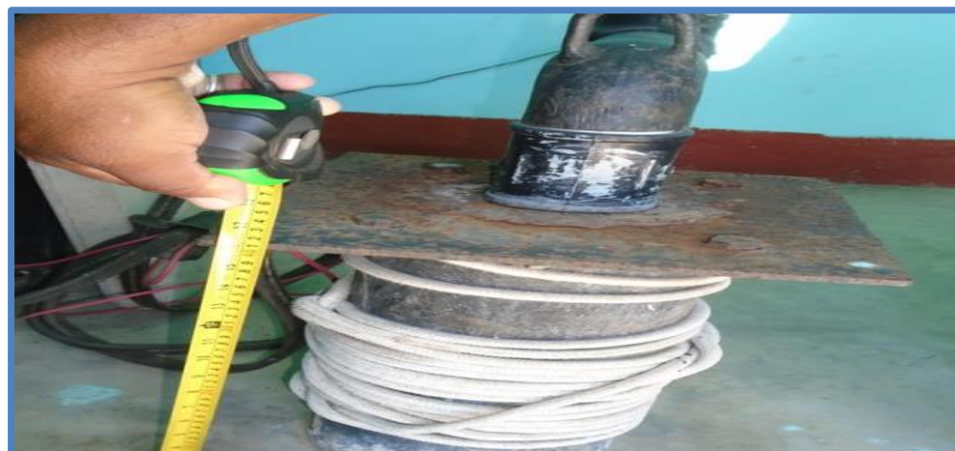
Fotografía 2 Línea de aducción
