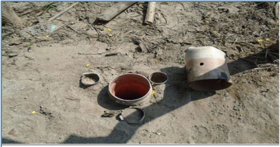
Fotografía 9 POZO TUBULAR IRHS-277 UTILIZABLE.
