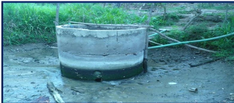
Fotografía 7 POZO TAJO ABIERTO IRHS-74
