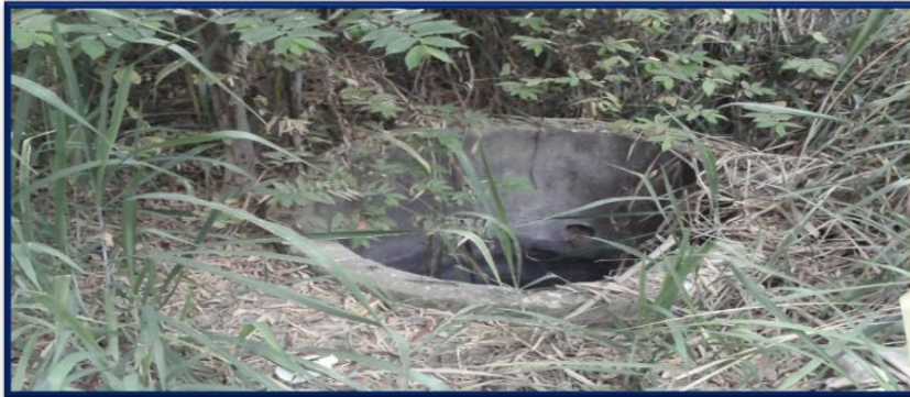
Fotografía 6 POZO TAJO ABIERTO IRHS-73
