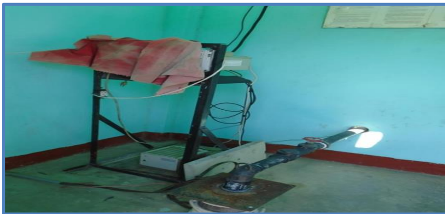
Fotografía 1 Caseta de bombeo
