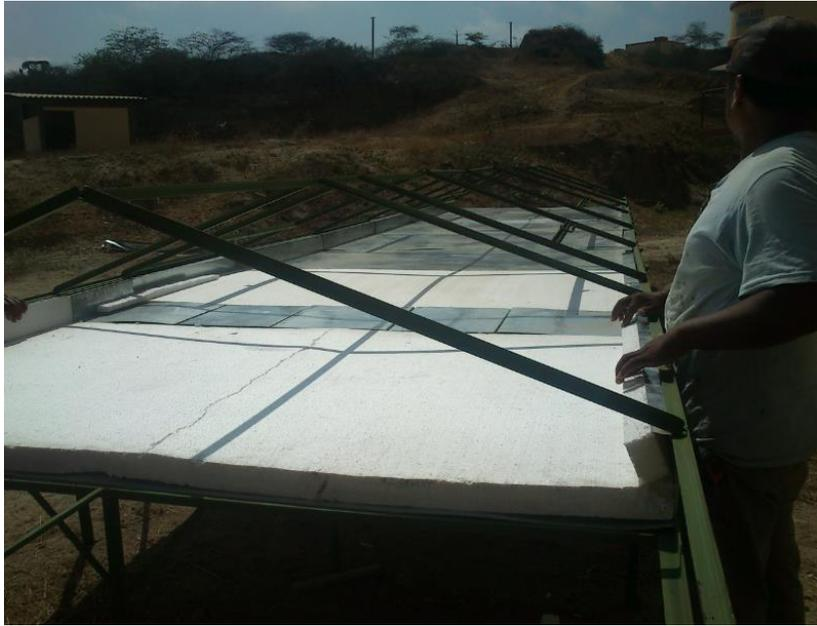
**Foto 3. Montaje de la plancha de poliuretano**
